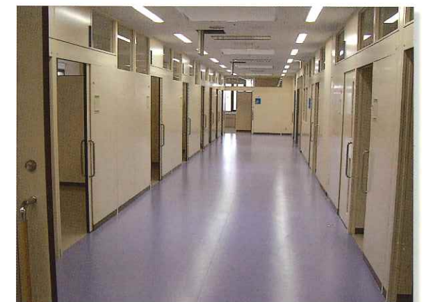
■小児科、産婦人科、中待合廊下 (診察室はプライバシー保護のため扉付きの個室仕様です)
