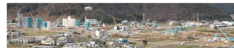
たくさんのクレーン車が並ぶ工事現場(当院屋上より 2020年1月撮影)
