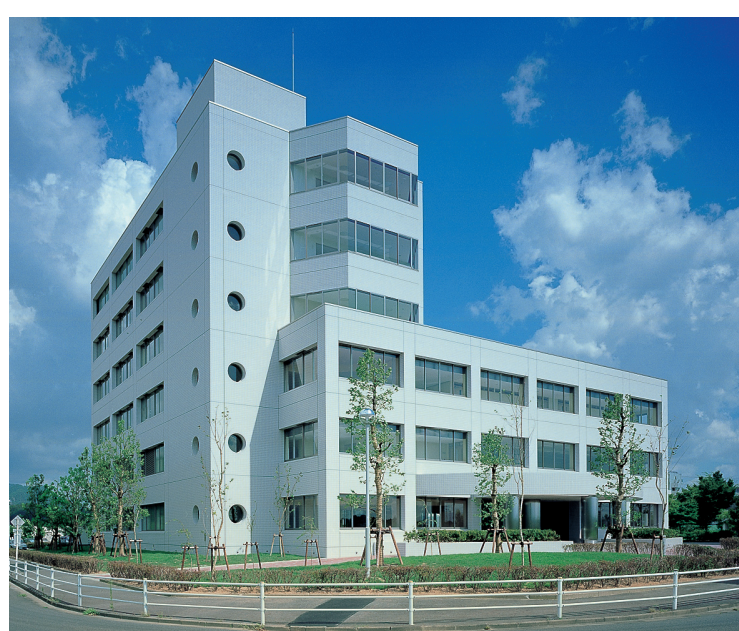
医学部看護学科 Nursing Course Building
